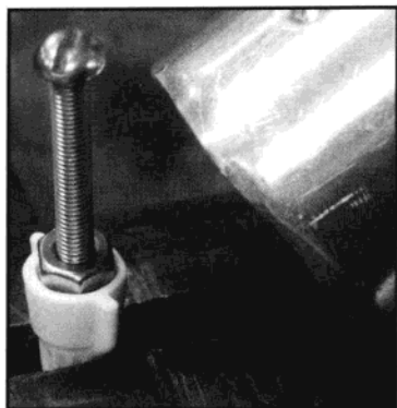
图 7.18 用热风枪把电缆连接器吹软。用环氧树脂把螺栓和电缆连接器固定。
